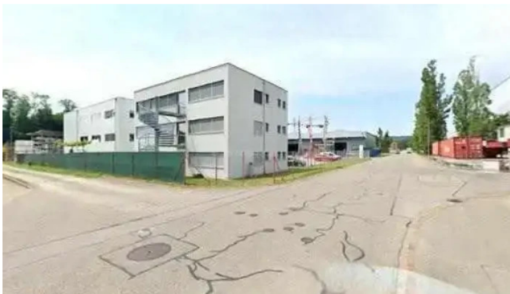
Steinhauser technik gmbh alle
