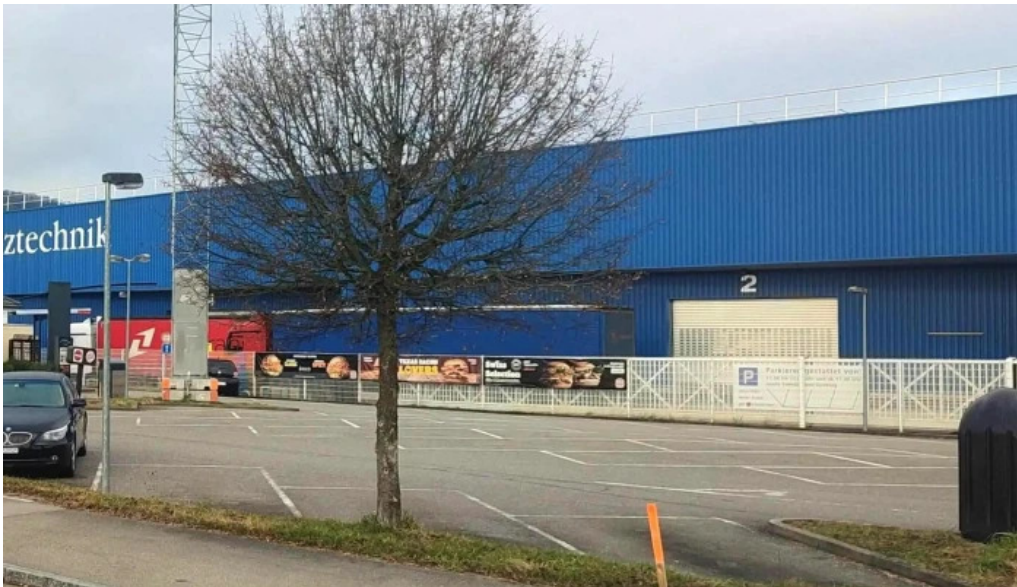
Bosch thermotechnik ag buderus schweiz spreitenbach heizung wärmepumpen meinungen
