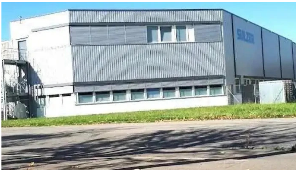
Sulzer chemtech ag allschwil
