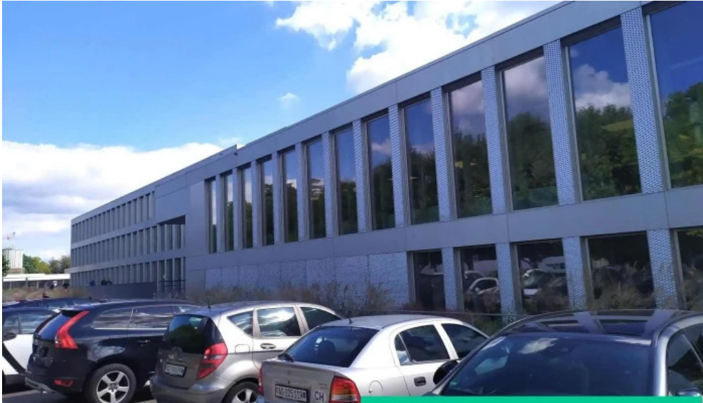
Strassenverkehrsamt des kantons aargau gebaude
