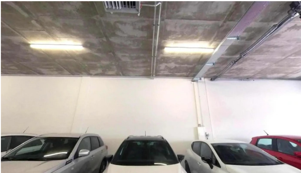
Autokom ag street view 360deg fotos
